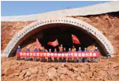
参建员工庆祝杭绍台铁路全线首条隧道贯通
