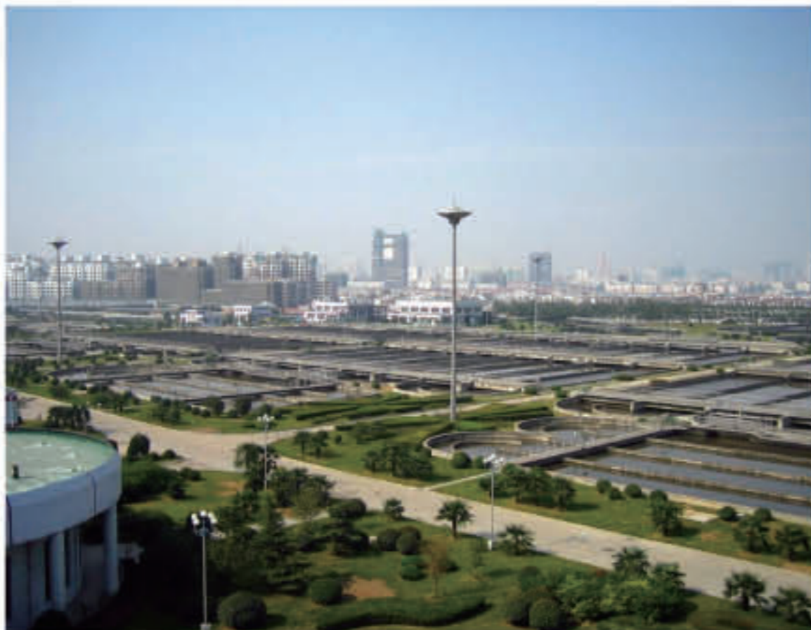
合肥王小郢污水厂
